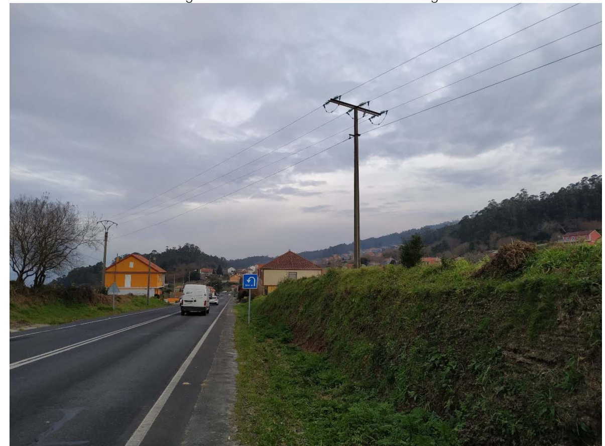
Fotografía 5. PO-551 P.K. 14+360 sentido Bueu
