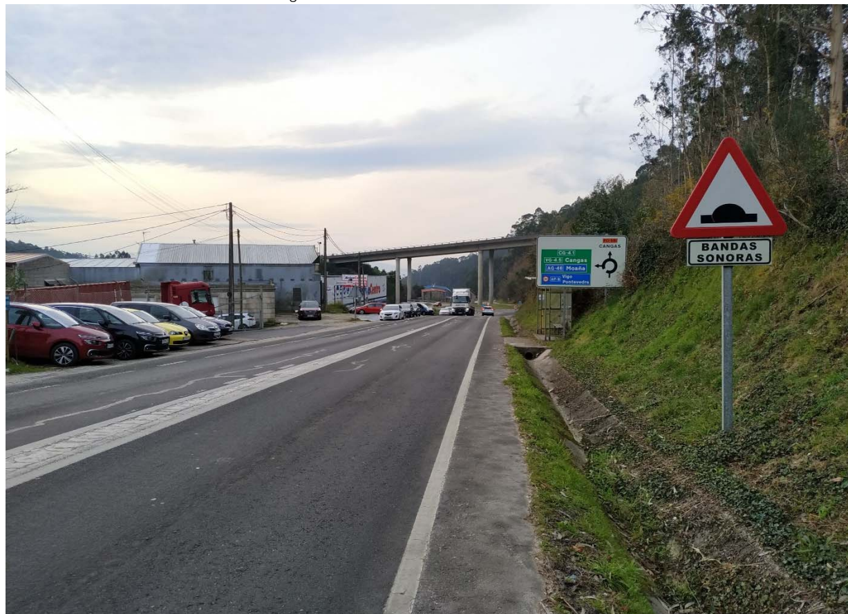
Fotografía 3. PO-551 P.K. 14+490 sentido Cangas
