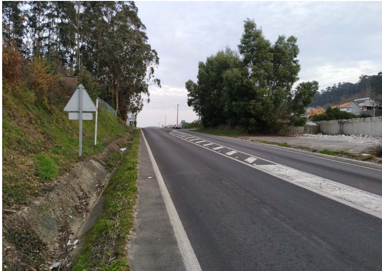
Fotografía 2. PO-551 P.K. 14+490 sentido Bueu
