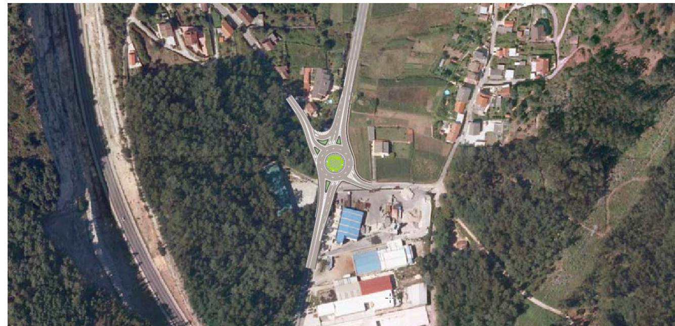
Figura 2. Imagen final de las obras
