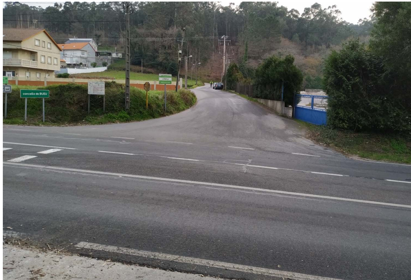
Fotografía 11. PO-551 P.K. 14+435. Situación actual del vial este de acceso a la glorieta
