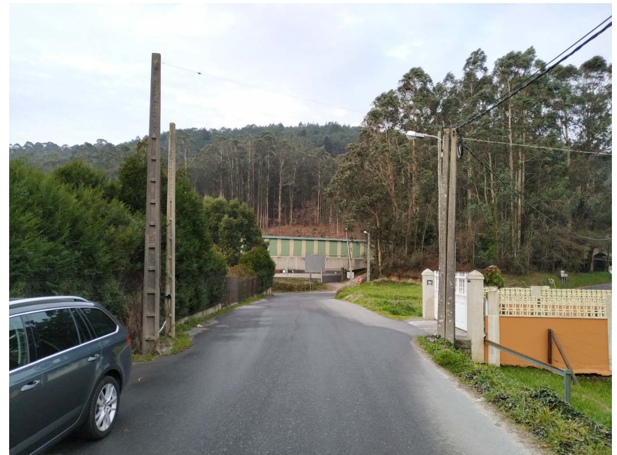
Fotografía 12. Vial este de acceso a la glorieta
