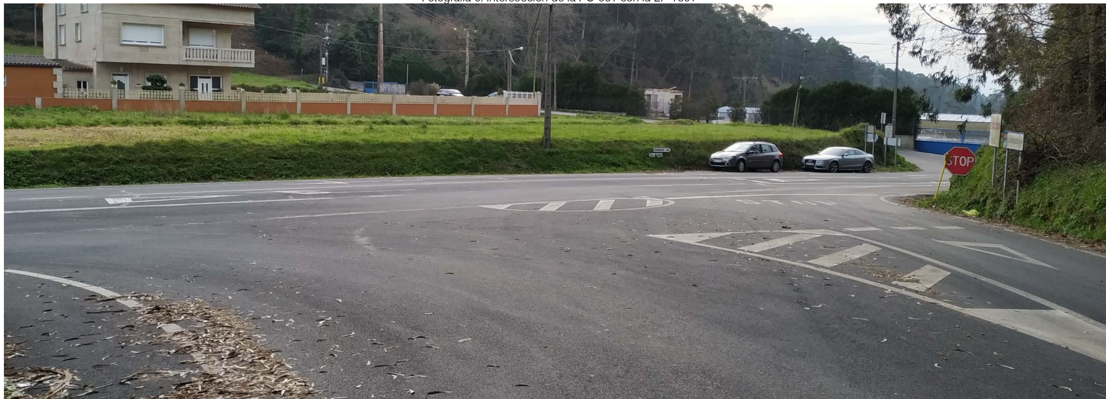
Fotografía 7. EP-1301 Intersección con la PO-551
